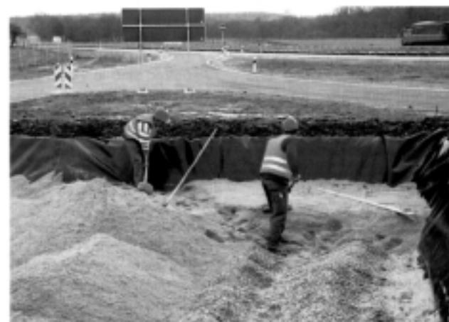
verlegtes Schlauchsystem sehr homogen auf dem gesamten bewachsenen Bodenfilter verteilt wird. Die Bemessung der Anlagen wurde in Anlehnung an das ATV-Arbeitsblatt A262, die DIN 4261 und die Verwaltungsvorschrift für Pflanzenkläranlagen des Landes Mecklenburg-Vorpommern vorgenommen. Das gereinigte Abwasser verlässt nach einer Verweilzeit von bis zu 29 Stunden den Vertikalfilter und wird in die Entwässerungsleitung der Autobahnstrecke abgegeben.
